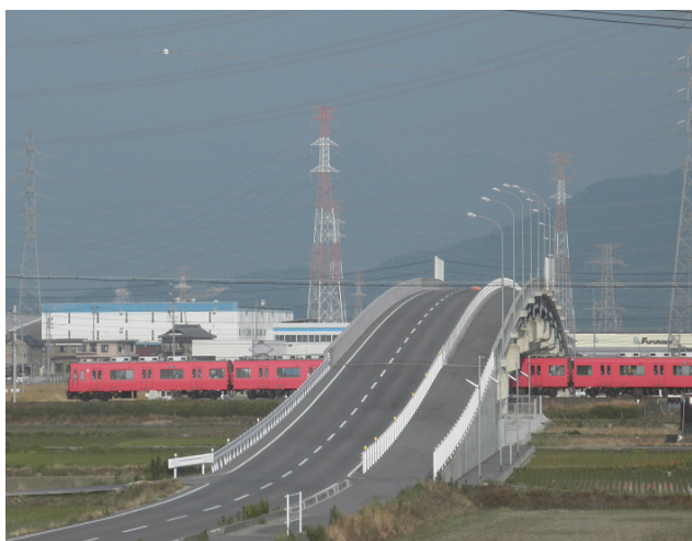
開通済区間（愛西市西保町） 跨線橋（名鉄尾西線）
