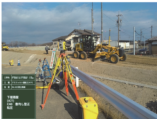
写真6 マシンコントロールによる施工状況
