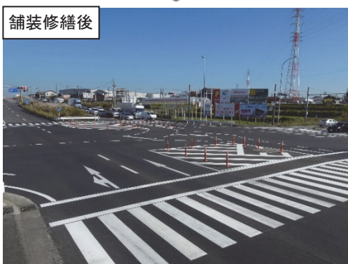
図 4 国道 155 号西三河車検場北交差点 【舗装修繕】
