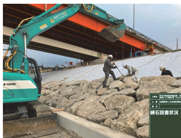
写真-3 練石張り工状況
