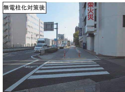
図3 国道1号岡崎康生 無電柱化対策
