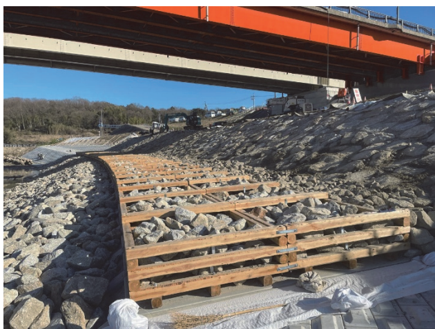
写真-6 木工沈床及び捨石設置完了
