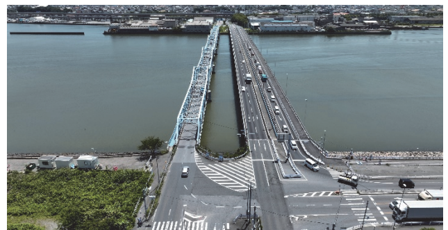
図19 工事の完了状況
