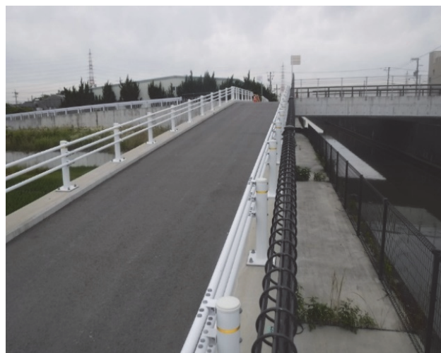
スロープ完了
