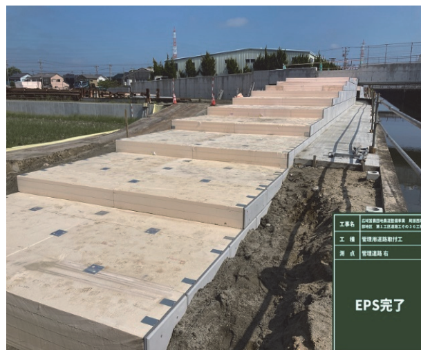
EPS 設置状況
