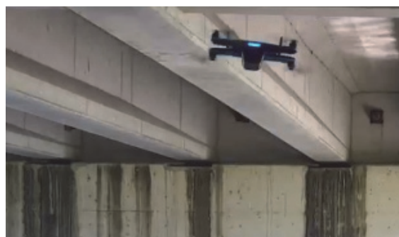
▲写真1 ドローンによる橋梁点検
