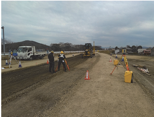
写真5 刃先の精度確認作業
