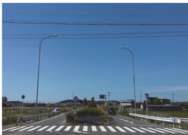
写真-1 着手前写真
