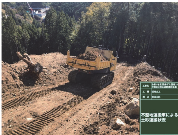
写真-4 不整地運搬車による土砂運搬
