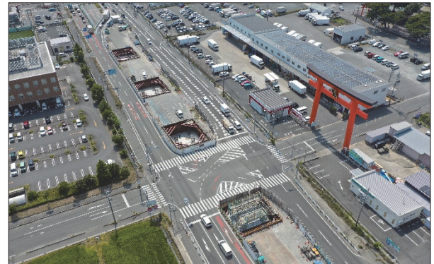
写真1 宮下東交差点付近 現道の切り回し状況
