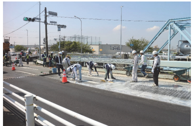
図 13 接着剤塗布状況
