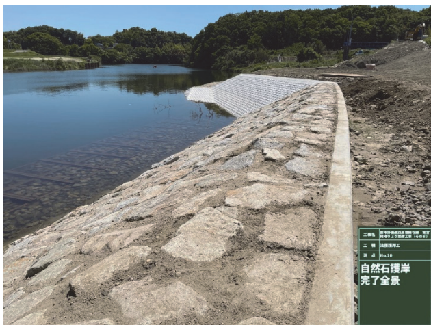
写真-4 練石積み完了
