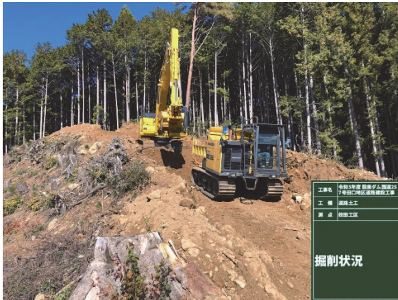
写真-3 掘削状況
