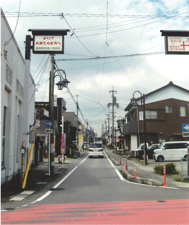
一車線一方通行の碧南駅前線
