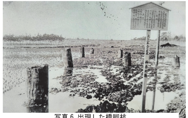
写真6 出現した橋脚杭 「旧相模川橋脚」パンフレットより
