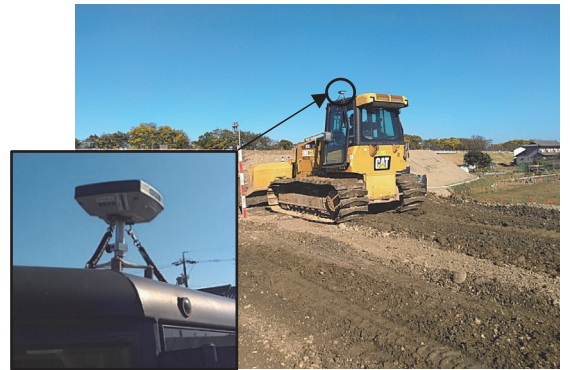
写真3 施工状況（締固め）
