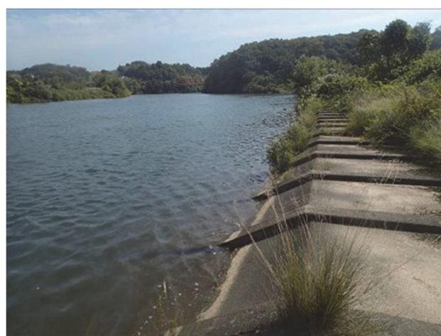
写真-1 既設護岸の水際
