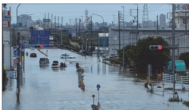
写真3 道路冠水状況（国道1号より宮下交差点を望む）
