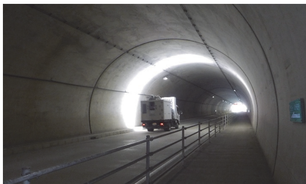
▲写真2 走行型画像計測車によるトンネル点検
