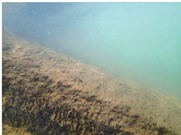
写真-2 既設の河床
