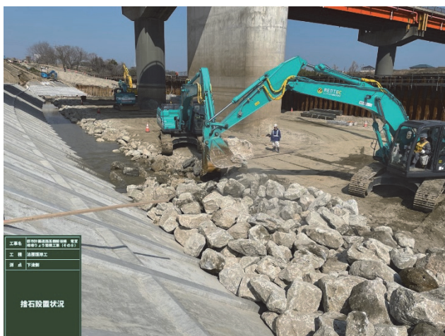
写真-5 捨石設置状況
