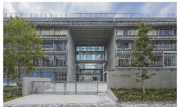
図 1 本校の外観（第 60 回 BCS 賞を受賞）
