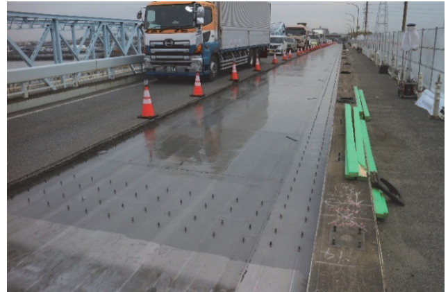
図 12 鋼床版の防錆実施状況
