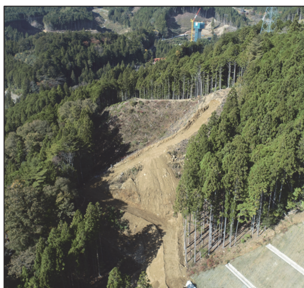
写真-2 出来上がった仮設道路
