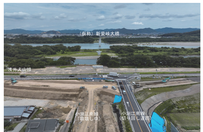
写真8 現場状況（令和6年8月現在）
