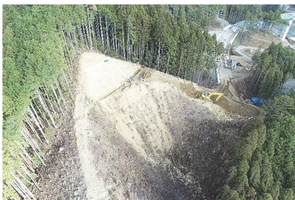
写真-5 施工状況全景
