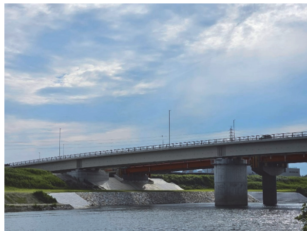
写真-7 左岸側から右岸を望む（施工後）
