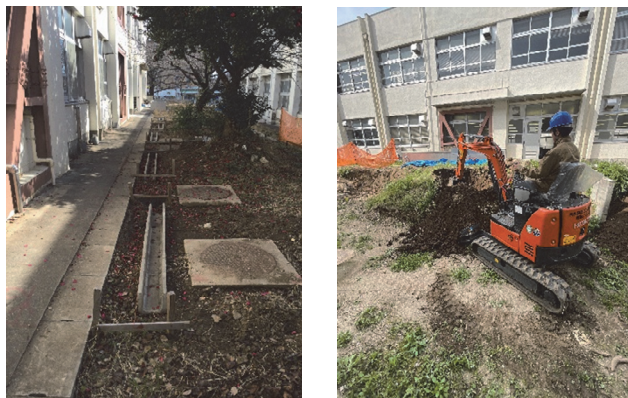
写真5・6 丁張り等の基礎から機械施工までを実施
