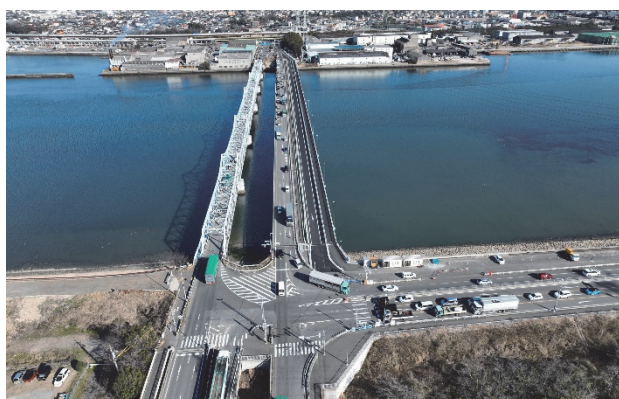
図 7 SFRC 着手前の状況
