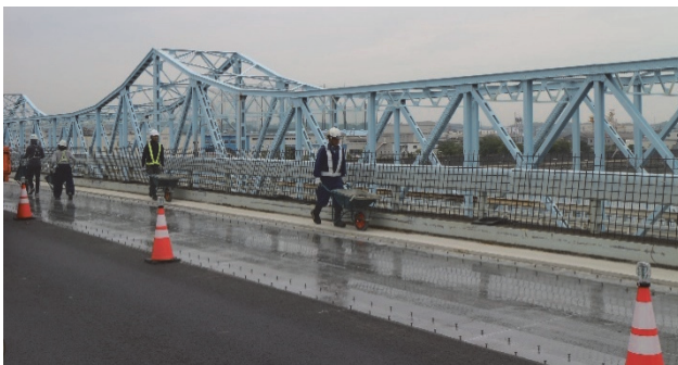
図16 先行打設箇所を用いた運搬状況
