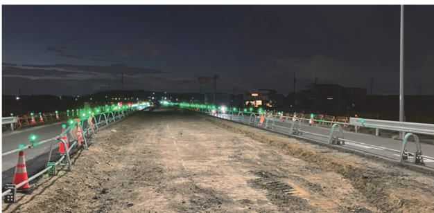
写真-2 同期点滅設置状況
