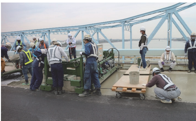
図17 SFRG 打設状況
