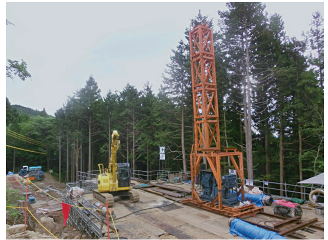
写真5 抑止杭の施工状況
