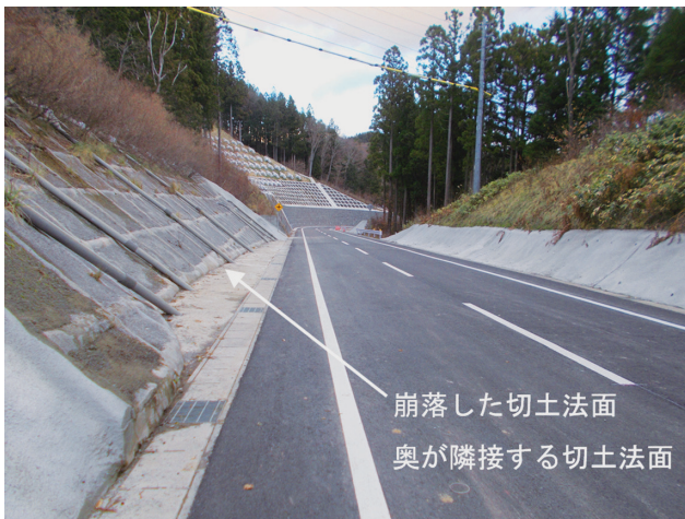
写真4 供用開始直前の道路
