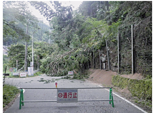
写真-3 3回目の法面崩壊状況(県道上)
