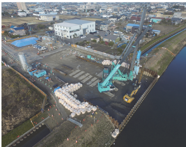
鋼管杭打込み状況
