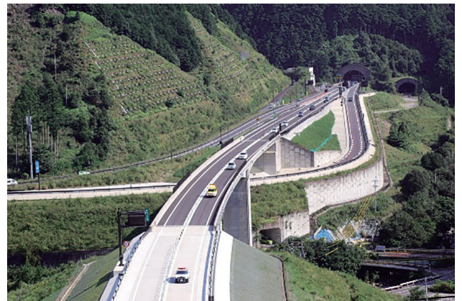
熊野尾鷲道路Ⅱ期 尾鷲南IC（R3.8撮影）
