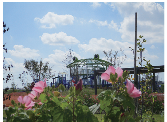
油ヶ淵水辺公園 ぶらりん広場 カエルの遊具（施工中）
