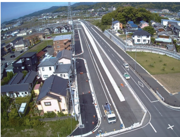
市道取り込み区間・4車化整備状況
