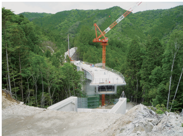
図-3. 4号橋梁施工状況（奥三河2期地区）
