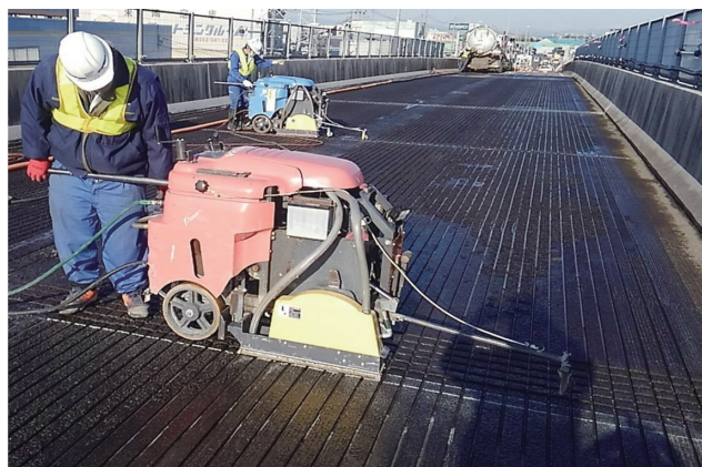
縦断・横断溝完了
