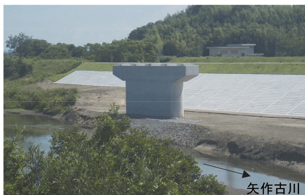
写真 1 P2 橋脚完成写真
