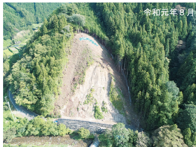
写真-4 頭部排土工着手時
