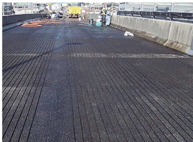
縦断・横断溝完了
