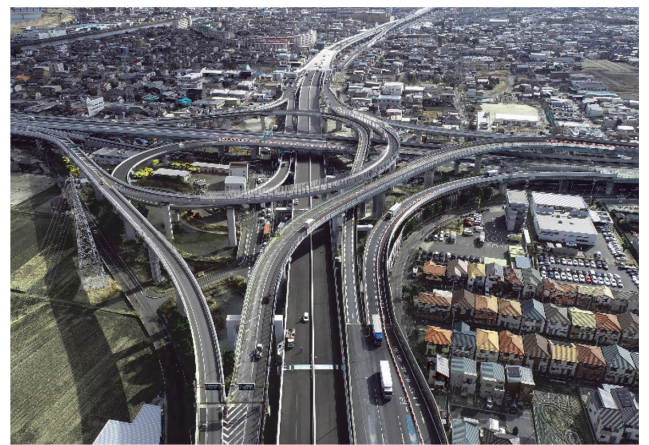
名古屋環状2号線 名古屋西JCT（R3.2撮影）
