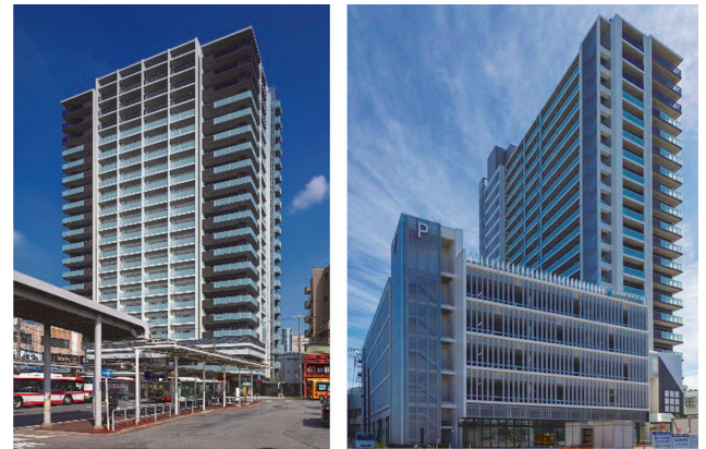
建物外観 (竣工後)
