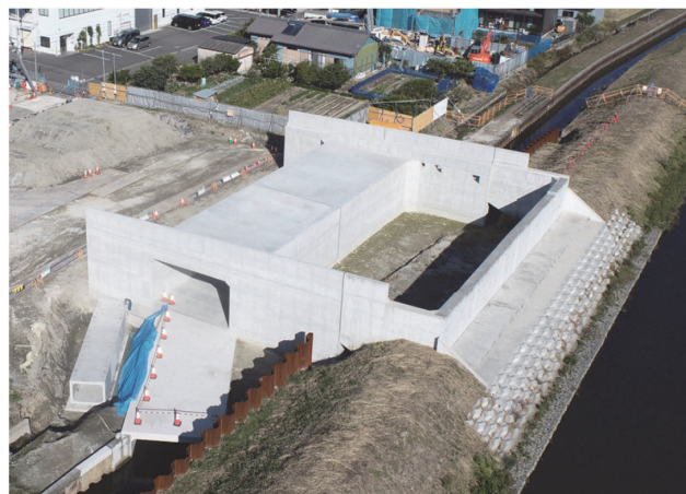
橋台・函渠コンクリート完了
