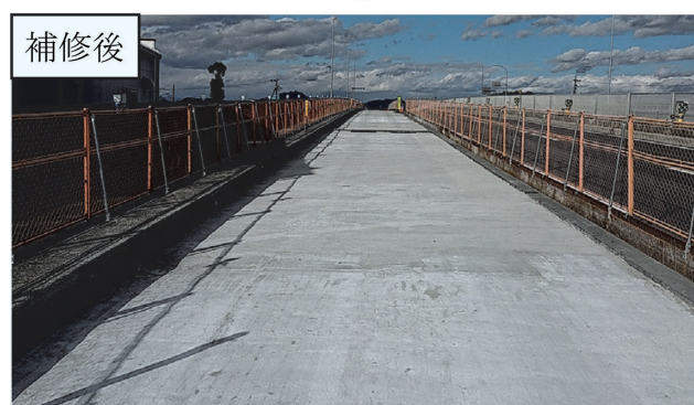
床版上面補修 国道22号 北方高架橋
