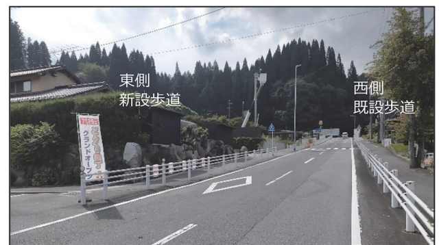
市道東側歩道の新設
