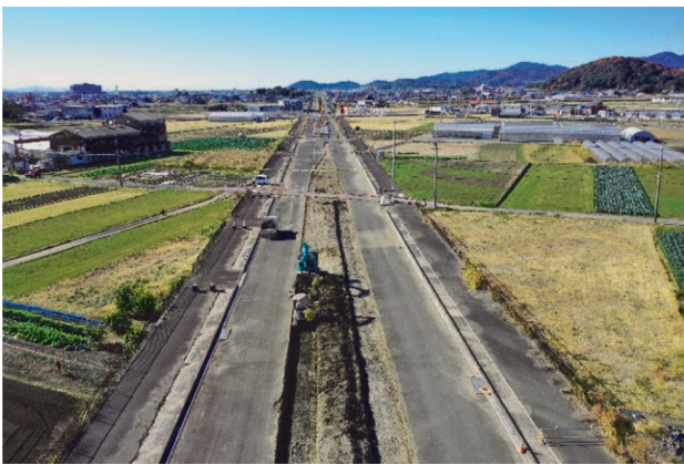
バイパス整備区間・4車化整備状況
