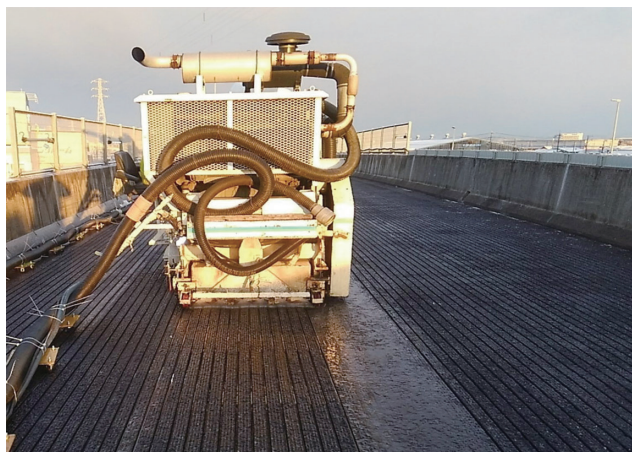
横断溝施工状況
