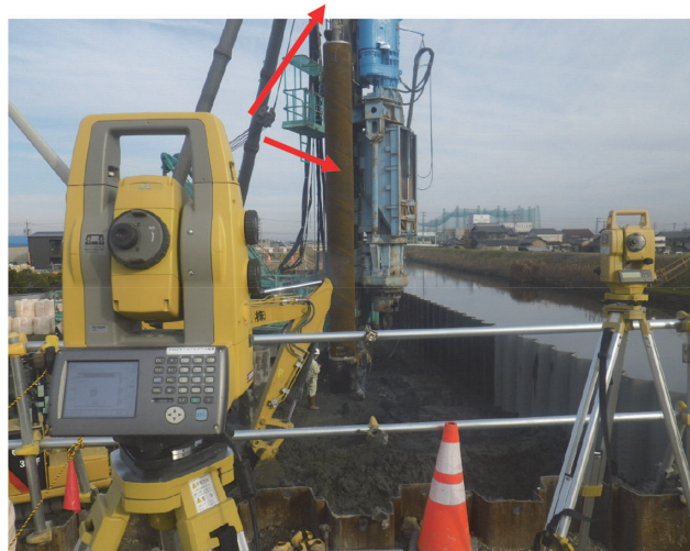
ノンプリズムトータルステーション計測状況
