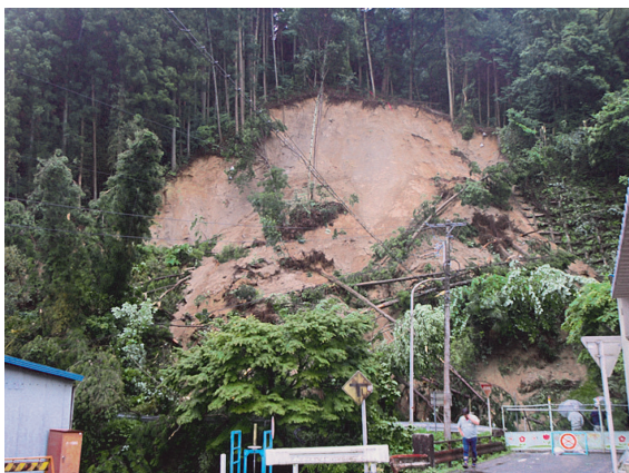
写真-2 3回目の法面崩壊状況(正面)
