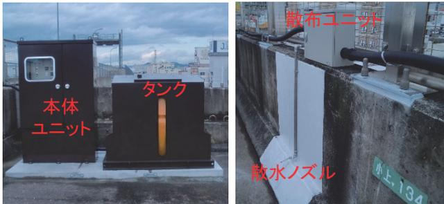
写真4 本体ユニット、タンク、散布ユニット、散水ノズル
