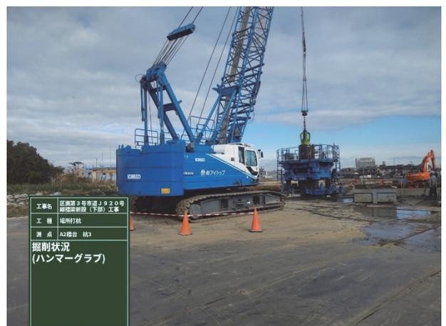
写真 3：場所打ち杭施工状況
