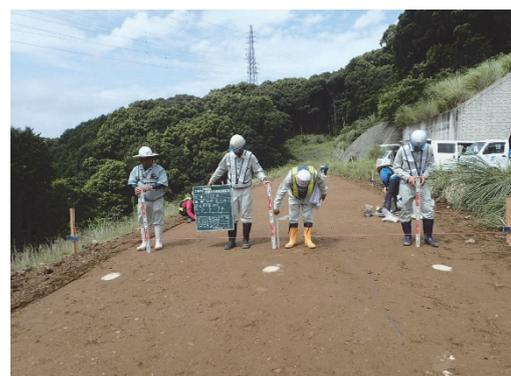
表面沈下量の測定
